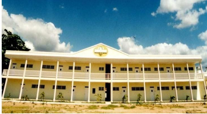
Foto 4 – Sobral: Prédio da Faculdade de Medicina da UFC
