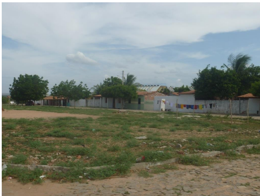
Figura 35 – Conjunto habitacional Dr. José Martins de Santiago (Mutirão Novo), no bairro Tabuleiro do Catavento.
