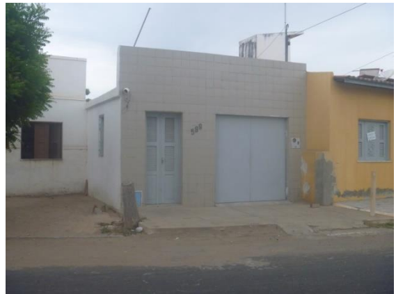
Figura 40 – Casa alugada no mercado informal por funcionários da Dakota-Russas, no bairro Vila Gonçalves
