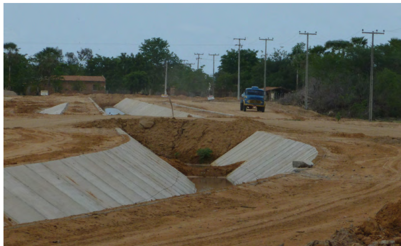
Obras do PITR
