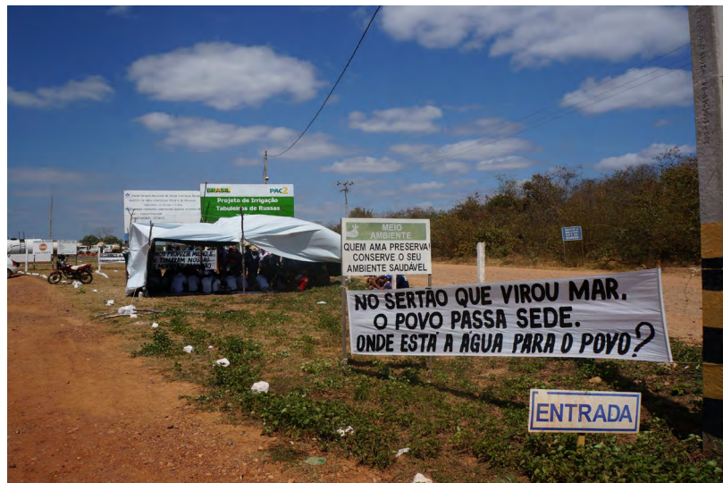
Ocupação do Canteiro de obras da PITR
