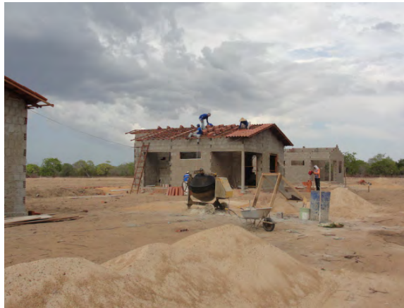
Construção das casas do reassentamento
