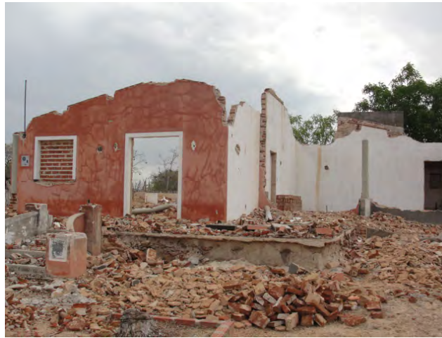
Casa destruída no Junco
