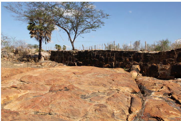
Muro construído por antigos habitantes do Cipó para o barramento de água
