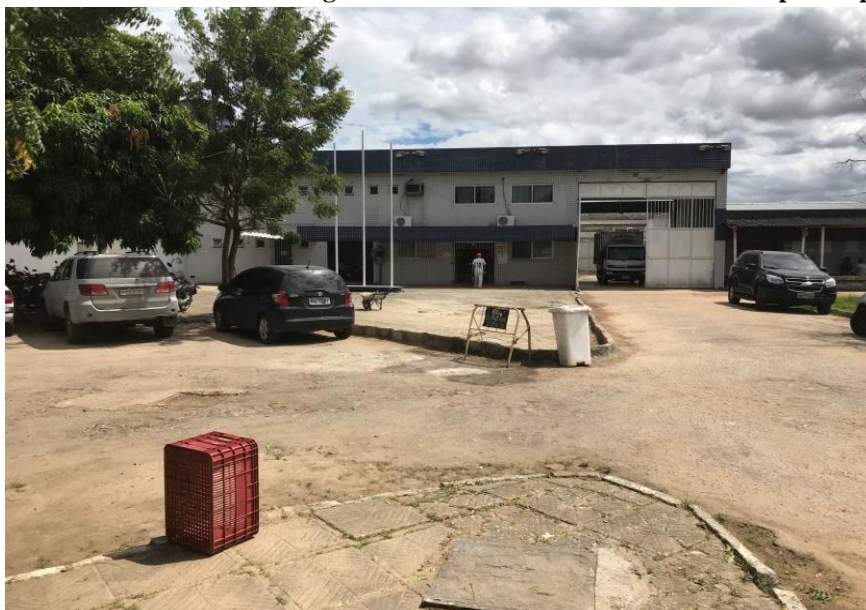
Figura 7 - Instituto Penal Desembargadora Auri Moura Costa – fachada do prédio principal.
